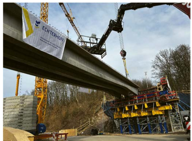
Bild 14 Fertigteile (Quelle: Echterhoff) Girders lifting
