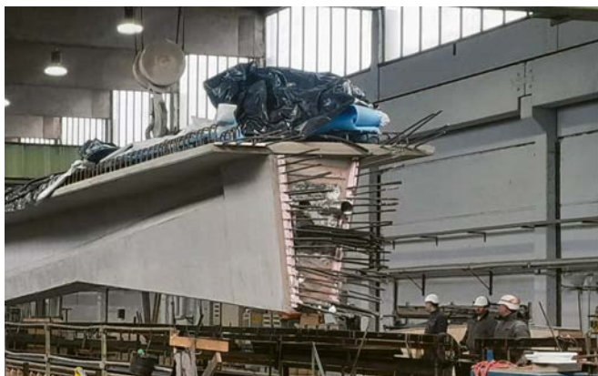
Bild 9 Aushub Fertigteile aus der Schalung (Quelle: ELO Beton Elementbau Osthessen) Excavation Precast elements from the formwork
