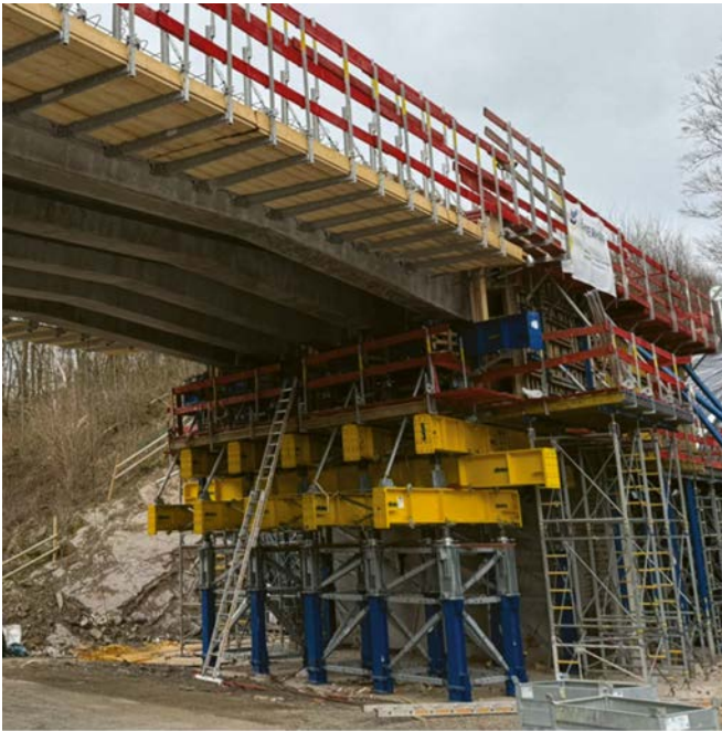
Bild 10 Traggerüst der Fertigteilträger (Quelle: Echterhoff) Support structure for precast girders
