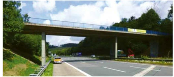
Bild 2 Bestandsbauwerk (Quelle: Die Autobahn GmbH) Old structure
