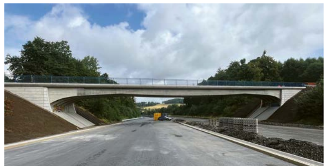
Bild 1 Bauwerk Fuelbecker Straße (Quelle: Echterhoff) Fuelbecker Straße Overpass
