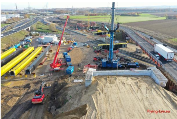
Abbildung 8: Ansicht Baufeld beim Einheben der Querträger (© Straßen.NRW)
