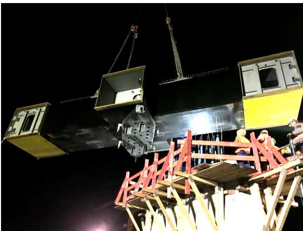
Abbildung 7: Einheben Querträger Achse 30 (© Fa. Züblin)
