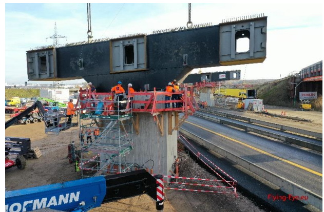
Abbildung 9: montierter Querträger in Achse 20 (© Straßen.NRW)
