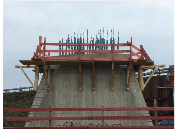
Abbildung 4: Ansicht Pfeiler Achse 30 vor dem Einheben des Stahlquerträgers (© Fa. Züblin)
