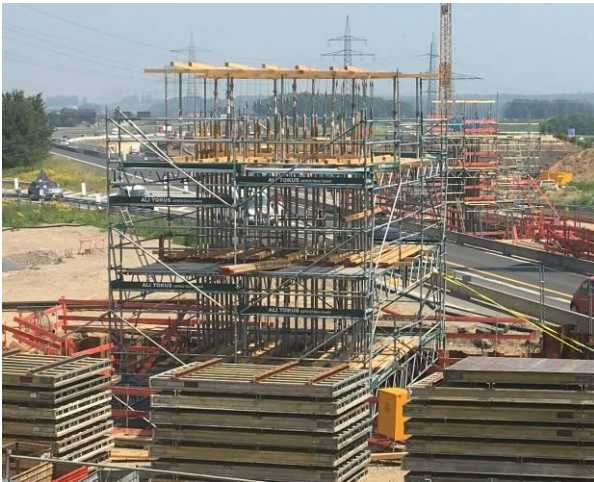
Abbildung 5: Ansicht Hilfskonstruktion Lagesicherheit Spannlieder (© Fa. Züblin)
