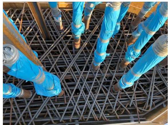
Abbildung 6: Detailansicht Pfeilerkopfbewehrung mit Hüllrohren (©DKK)
